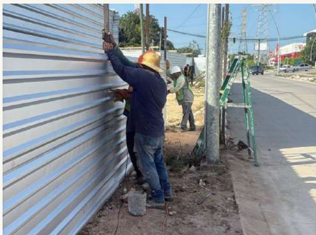
01 • Obras preliminares y confinamiento
